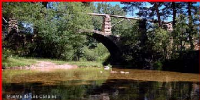
Puente de Los Canales
